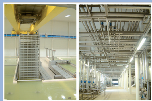
De Klokslag Salzbad zur Käsebehandlung/ GEA TDS Betriebsanlage zur Käseemilchbehandlung
